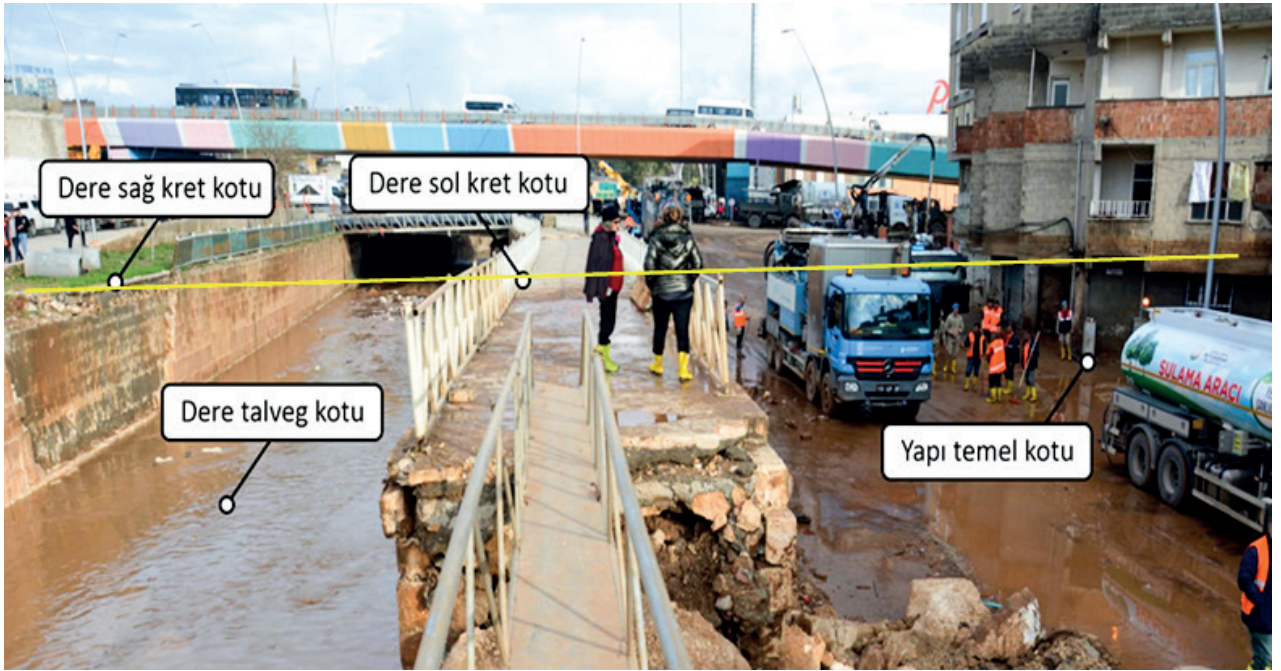
Şekil 4. Şanlıurfa'da yer alan Karakoyun Deresi etrafında yer alan yapılara ait fotoğraf
