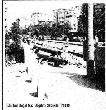
İstanbul Doğal Gaz Dağıtım Şebekesi inşaatı
