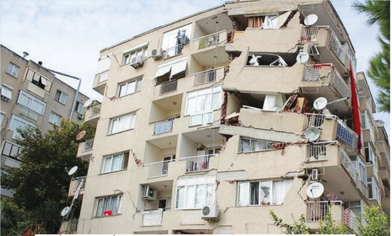
Şekil 2. İzmir Depreminde İmar Affından Yararlanarak Yapı Kayıt Belgesi Alan Binanın Deprem Sonrası Durumu
