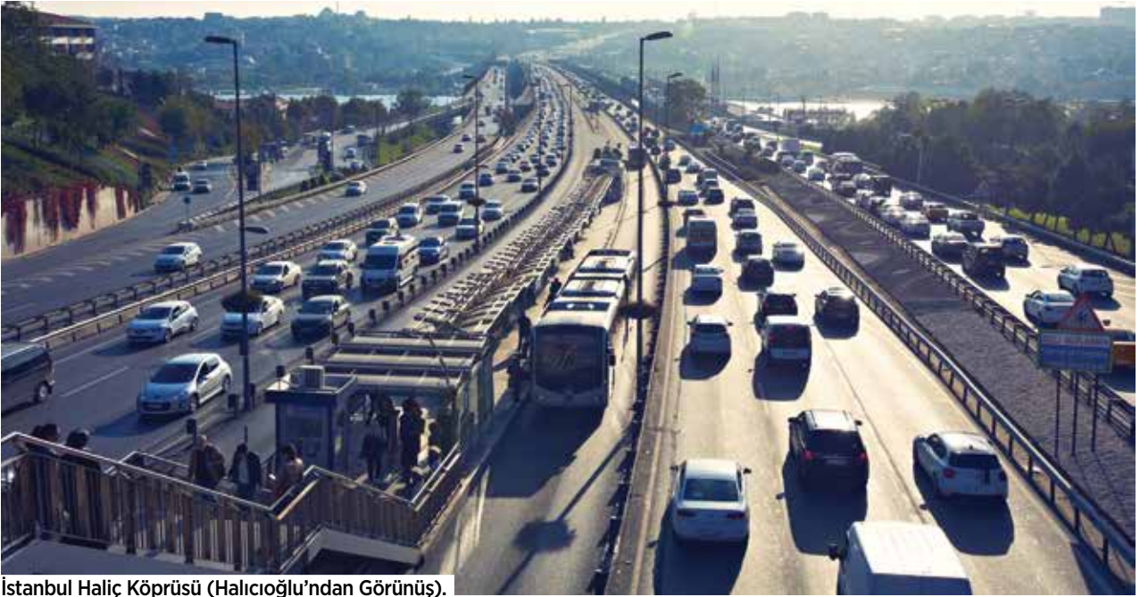
İstanbul Haliç Köprüsü (Halıcıoğlu'ndan Görünüş).
