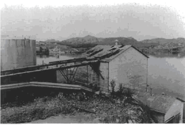
Şekil 5 - Tesisin patlamadan sonraki görünüşü
